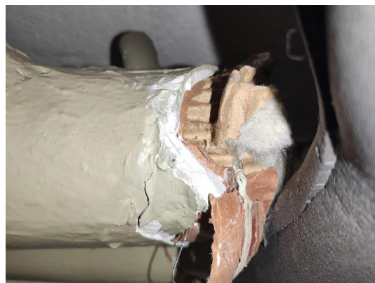
Abbildung 16: Gipsummantelung mit KMF
