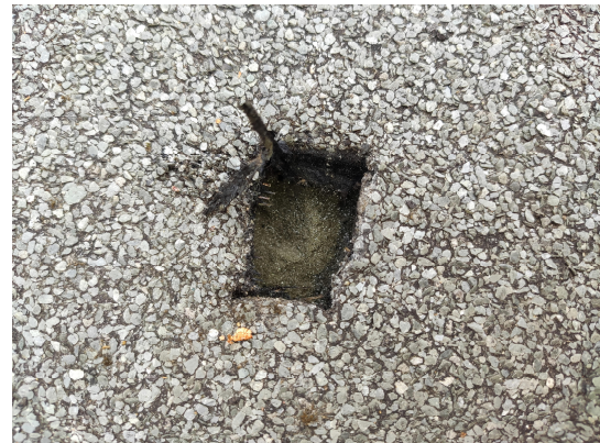
Abbildung 28: Dachpappe und Foamglas
