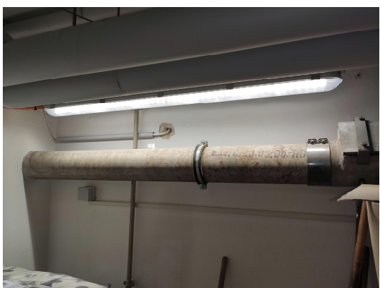
Abbildung 19: Asbestzementrohr
