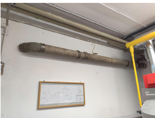
Abbildung 20: Asbestzementrohr 2
