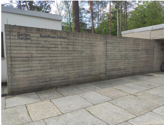
Abbildung 21: Sichtbetonwand
