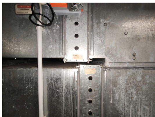
Abbildung 18: Flanschdichtungen
