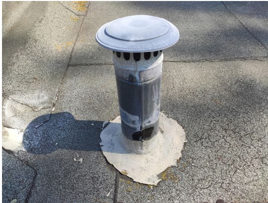
Abbildung 5: Entlüftungshaube
