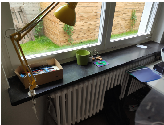
Abbildung 28: Fensterbank mit Asbest
